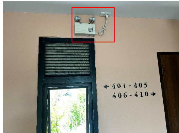
รูปที่ 3.2-38 ไฟส่องสว่างฉุกเฉิน (Emergency Light)
