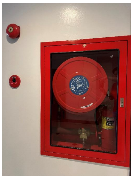
รูปที่ 3.2-34 ตู้เก็บอุปกรณ์ดับเพลิง (FHC)
