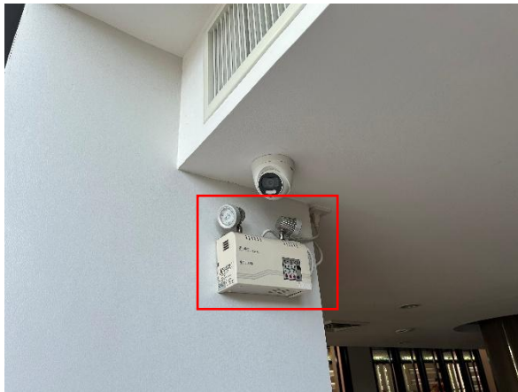
รูปที่ 3.2-38 ไฟส่องสว่างฉุกเฉิน (Emergency Light)
