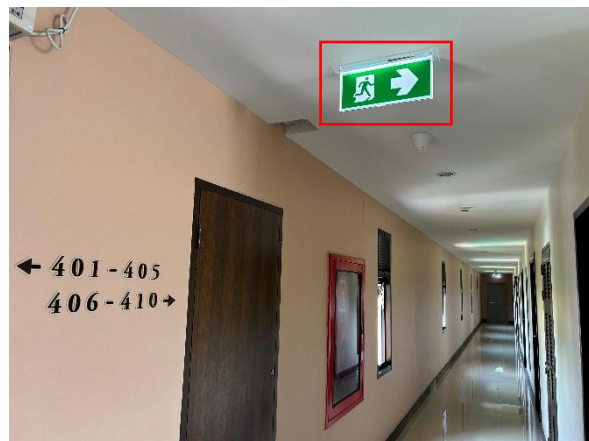
รูปที่ 3.2-39 ป้ายบอกทางหนีไฟ (Fire Exit Light)
