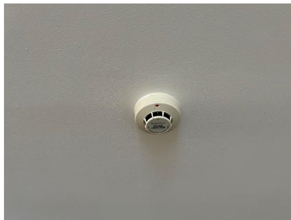
รูปที่ 3.2-36 เครื่องตรวจจับควัน (Smoke Detector)
